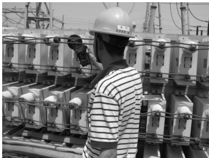
图 4 仪器现场测量实例
